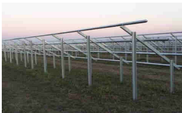
Esempio di posa delle strutture portanti.
