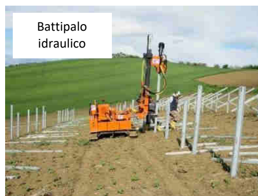
Esempio di posa delle strutture portanti.
